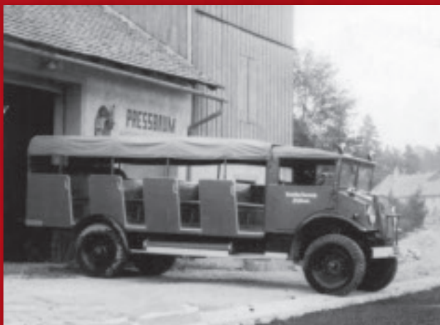
Abb. F-7: In Eigenregie zu einem Mannschaftstransportfahrzeug umgebauter Militär-LKW (1950)
