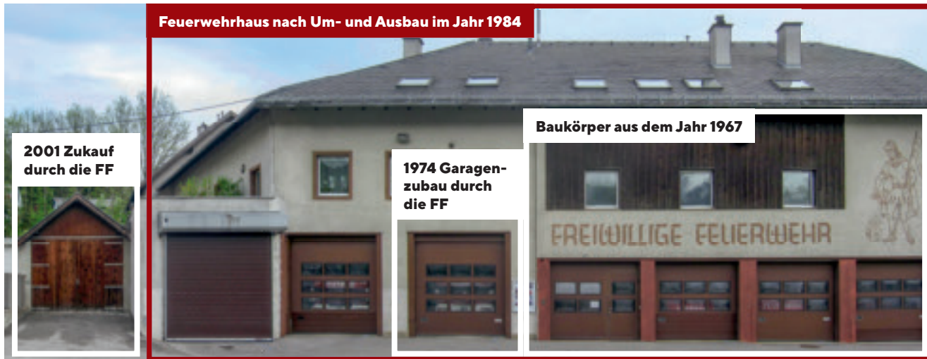
Abb. H-10: Feuerwehrhaus-Bauzustand nach dem Einbau der automatischen Garagen-Gliedertore 1992 und der Garagen-bodenabsenkung für das Schwere Rüstfahrzeug 2010 (Garage ganz links) sowie Darstellung der einzelnen Baustufen
